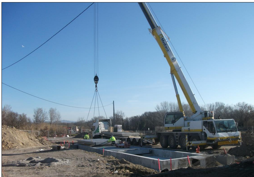
Photo : Mise en place des modules du pont.
