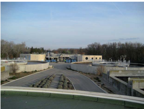
Station d'épuration de Salon de Provence (boues activées)
