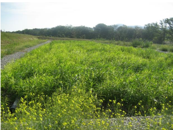
Station d'épuration de Vernègues-Cazan (Filtre planté de roseaux)
