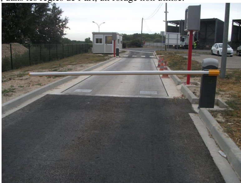
Photo : Pont bascule en service
