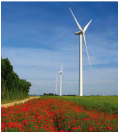
Le parc éolien du Pays Civraisien a été mis en service en juin 2014
