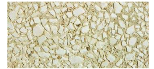
Béton de pierres calcaires, finition désactivée
