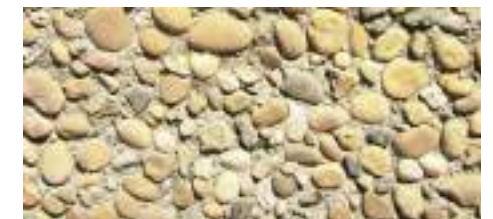
Béton de galets, finition désactivée
