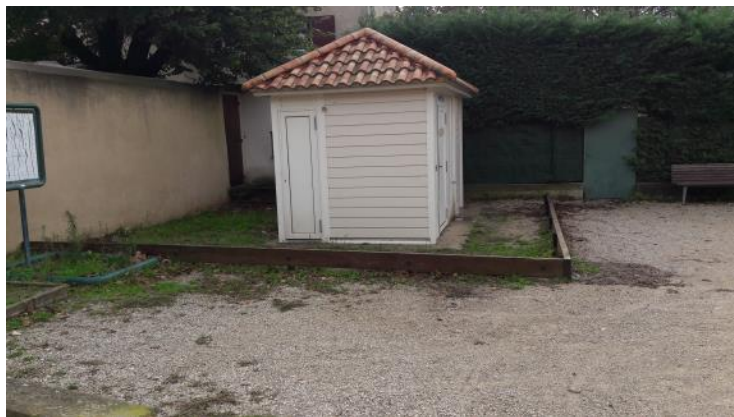
Le cagadou : un équipement indispensable dont l'intégration esthétique est améliorable
