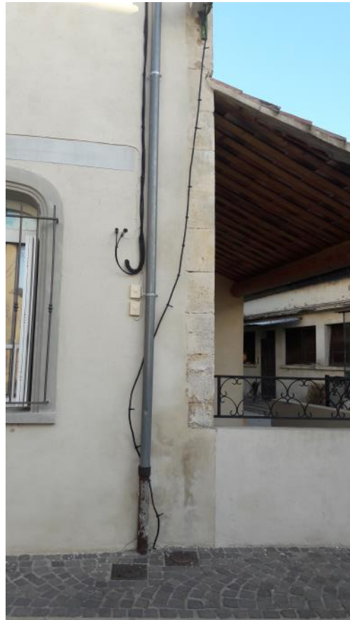
Quelques cheminements de câbles peu esthétiques
