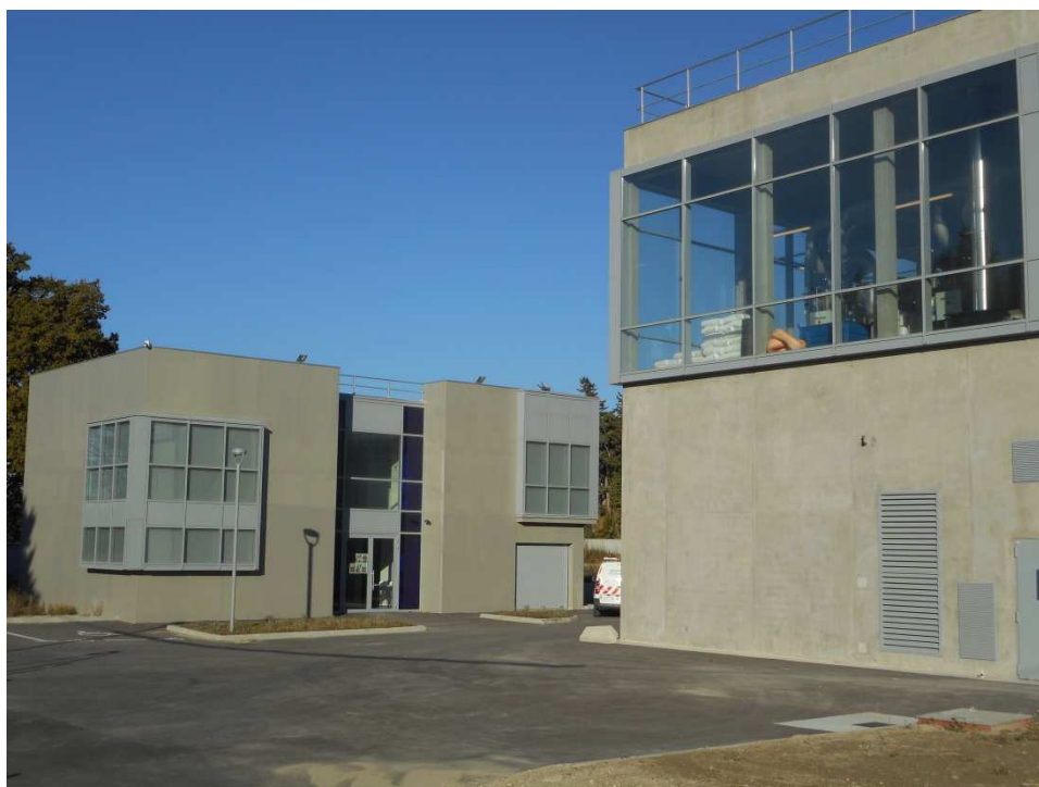
Unité de production d'eau potable de Salon-de-Provence - novembre 2017
