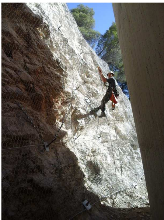
Travaux de confortement de la falaise des Goules – octobre 2017
