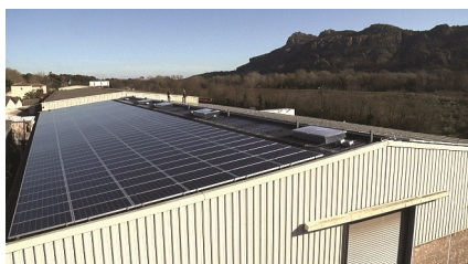
Exemple d'une installation photovoltaïque sur bâtiment
