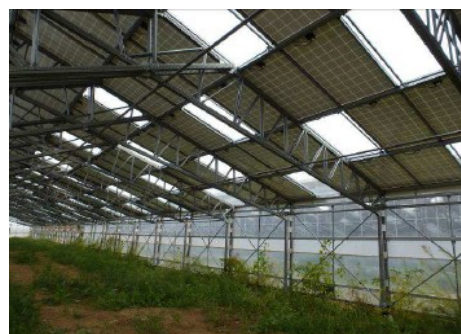
Serre avec modules en damier
