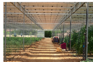
Allée centrale d'une serre PV
