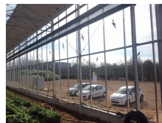
Dispositifs effaroucheurs en paroi latérale pour la protection des oiseaux
