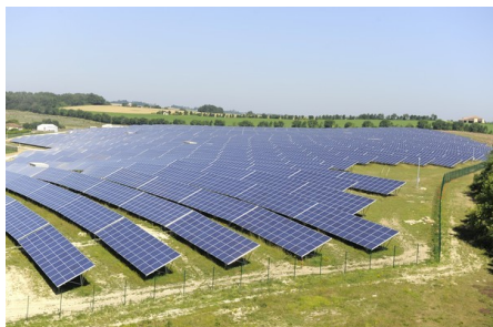
Exemple d'une centrale photovoltaïque au sol « classique »
