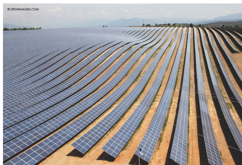
Centrale photovoltaïque au sol
