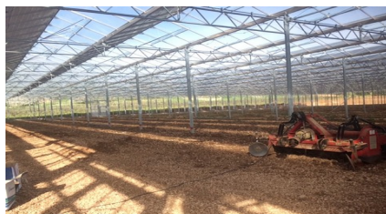
Intérieur d'une serre PV cathédrale
