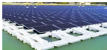
Exemple de centrale photovoltaïque flottante →
