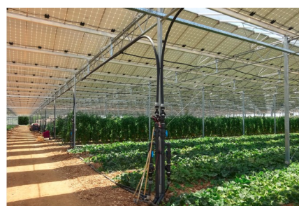
Système d'arrosage d'une serre PV
