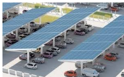
Exemple d'une installation photovoltaïque sur ombrière de parking
