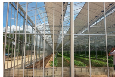
Paroi latérale d'une serre PV
