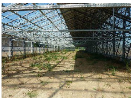
Serre avec modules déportés
