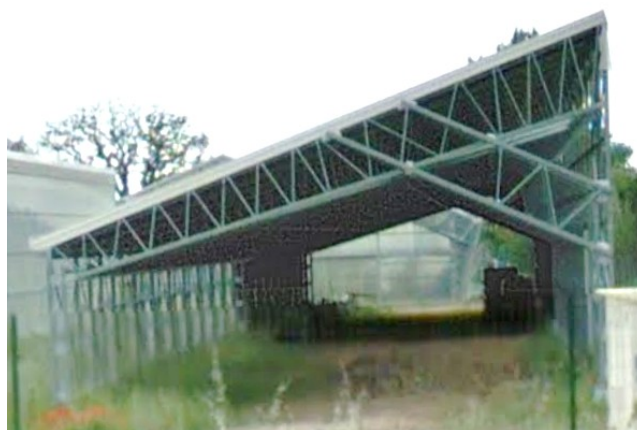
Serre PV « monopente » sans aucune activité agricole
