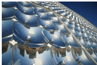
Champ photovoltaïque avec modules à concentration
