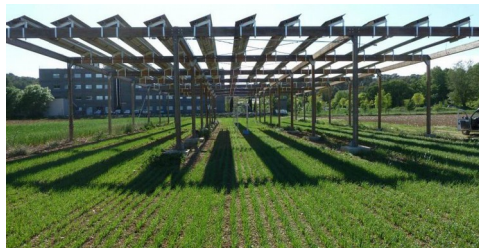
Exemple d'une installation agrivoltaïque
