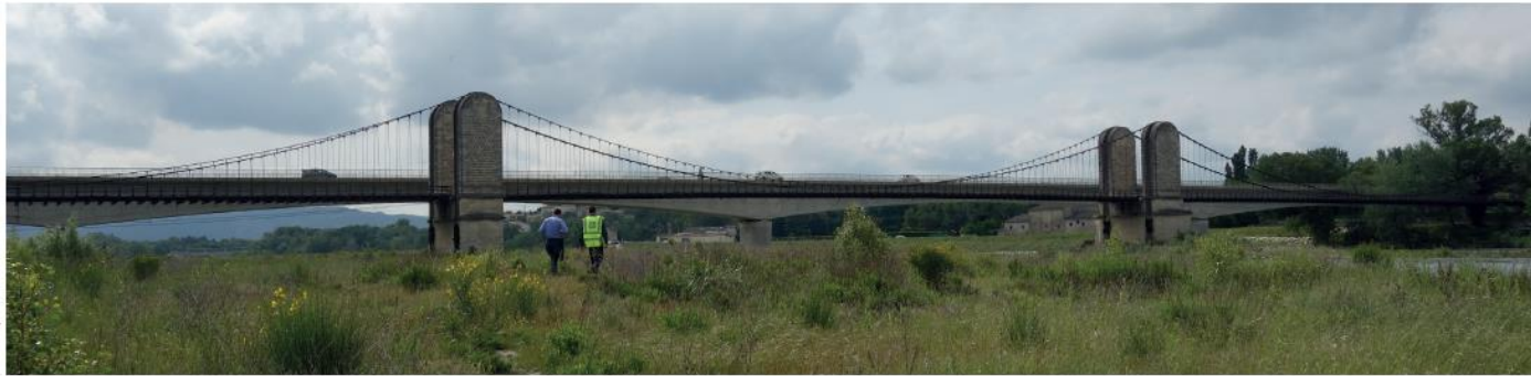
Figure 4 : Vue d'ensemble du Pont suspendu, depuis le lit de la Durance, à l'ouest de l'ouvrage, côté Mérindol [84]
