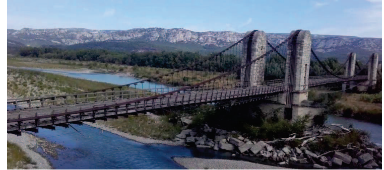
Figure 1 : Photo du vieux pont depuis le pont de la RD
