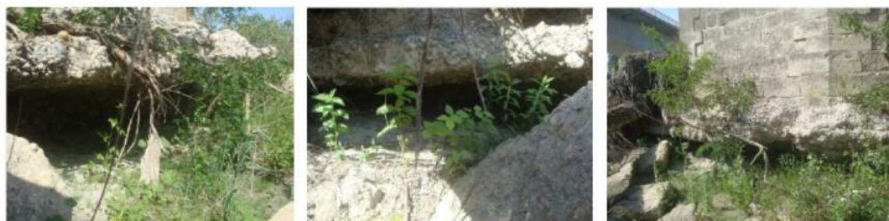
Figure 9 : Affouillement existant sous la pile P2 (setec, 2020)
