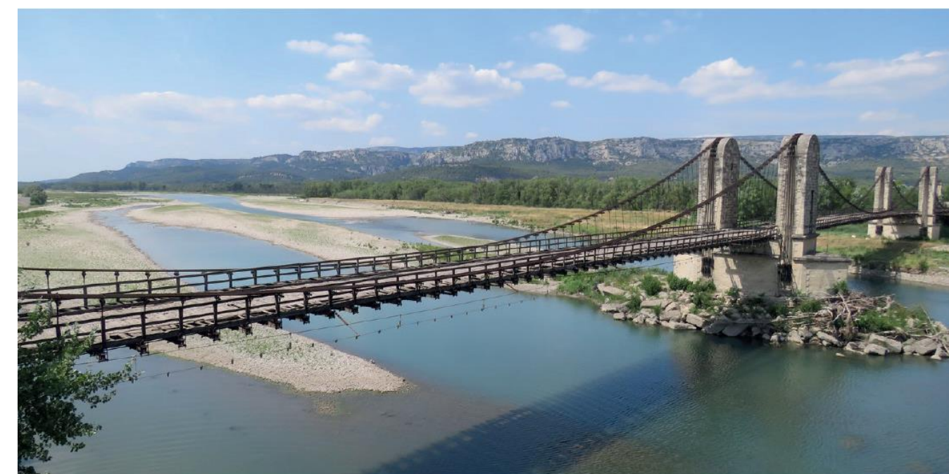
Figure 3 : Vue d'ensemble du Pont suspendu, depuis le nouveau pont à l'est de l'ouvrage, côté Mallemort (13)
