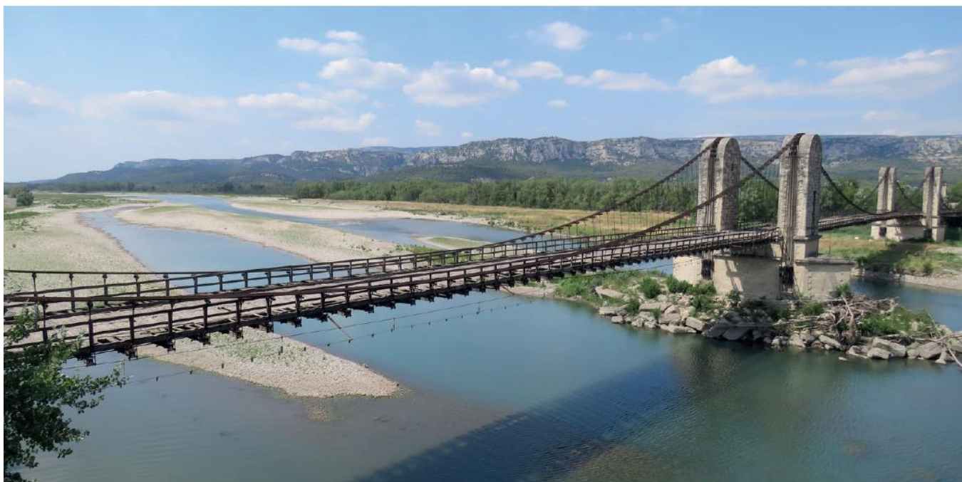
Figure 8 : Vue d'ensemble du Pont suspendu, depuis le nouveau pont à l'est de l'ouvrage, côté Mallemort (13)
