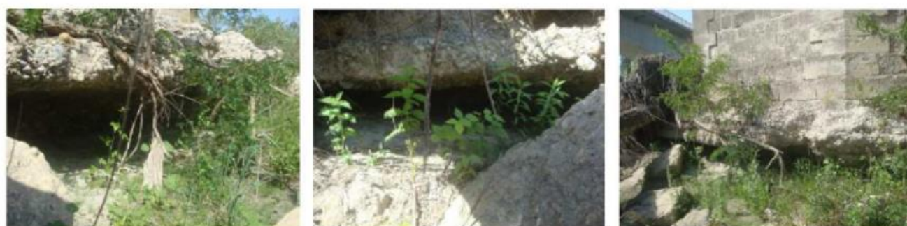
Figure 14 Affouillement existant sous la pile P2 (setec, 2020)
