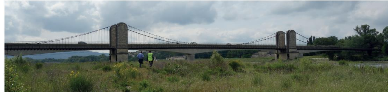
Figure 9 : Vue d'ensemble du Pont suspendu, depuis le lit de la Durance, à l'ouest de l'ouvrage, côté Mérindol [84]
