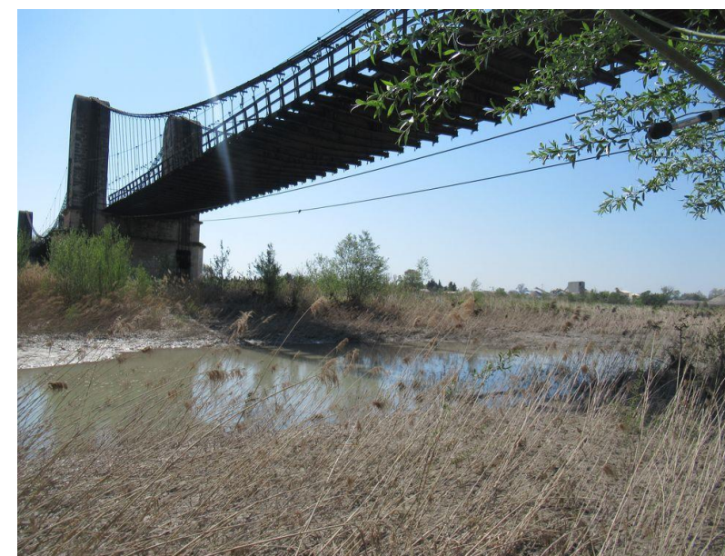
Figure 2 : Pont suspendu de Mallemort, ouvrage franchissant la Durance (Photo : NATURALIA)
