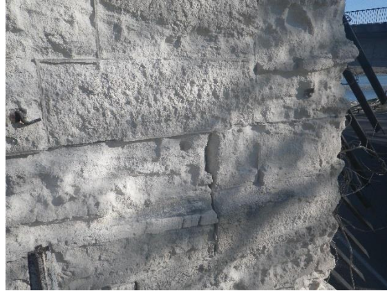
Pile P1 Aval - Vue sur la zone d'essai altérée
