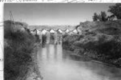
3 Aqueduc du Vallat Madame sur le Canal de Boisgelin
