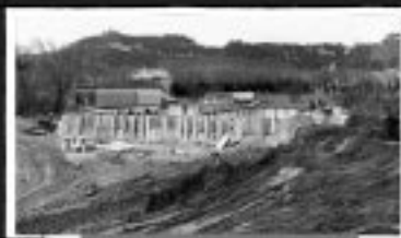
3 Construction du seuil pour Canal EDF
