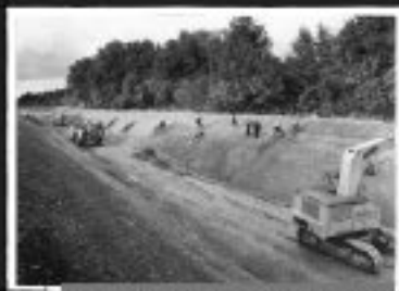
4 Excavation Canal Camille Bergès à Capenne
