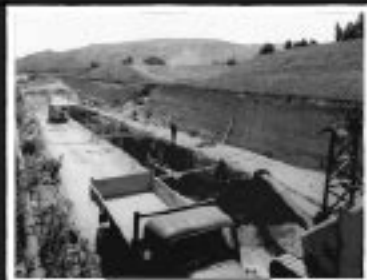
1 Travaux d'excavation Canal EDF
