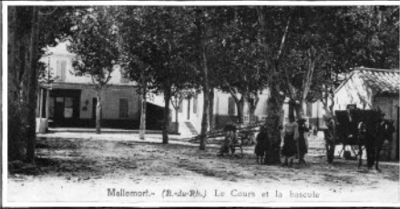
Mallemort.- (B.-du-Rhône.) Le Cours et la bascule
