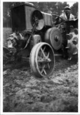
TRACTEUR VIERZON À POULE CHAUDE FABRIQUÉ EN FRANCE
